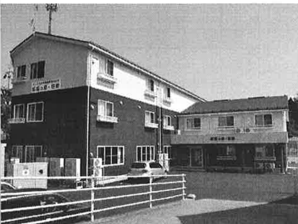
▲松福の郷・好摩 敷地面積1,056.87㎡(319.70坪) 延床面積1,181.28㎡(356.61坪) 2013年5月開所 木質枠組壁工法3階建(ツーバイフォー) 耐火建築物 居室22室
