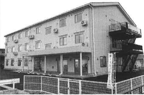
▲タロ北上大通り 敷地面積1,324.00㎡(400.59坪) 延床面積1,632.00㎡(493.68坪) 2010年4月開所 鉄骨造3階建 耐火建築物 居室30室
